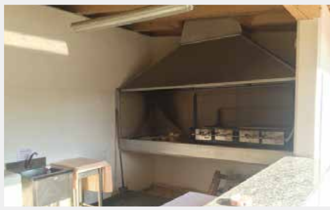
Fabbricato che ospita il barbecue
