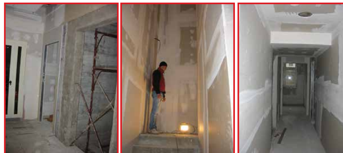
Il cantiere del nuovo oratorio: le aule di catechismo
