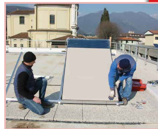
posa dei pannelli solari nel nuovo oratorio
