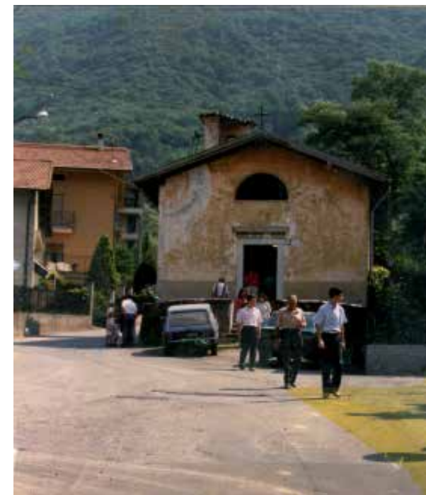
L'esterno della chiesetta di S.Rocco
